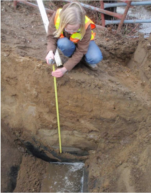
Fill material in a barnyard
